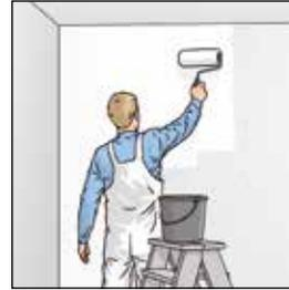
Enduire largement et régulièrement le support sur une largeur de 1 à 2 lés avec le système de collage ERFURT-SR 2 en utilisant un rouleau à longs poils.
