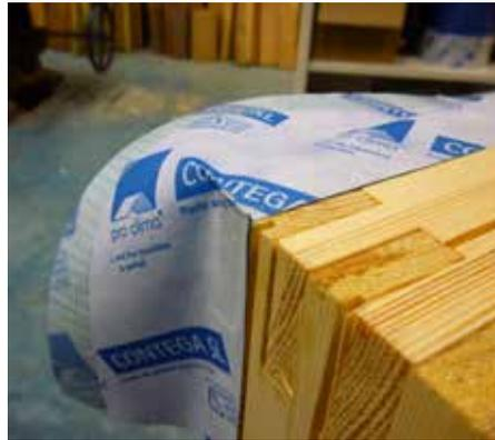
Photos ci-dessus, dans le sens des aiguilles d'une montre: fenêtre de toit avec "jupe" en Celit 4D sur toute la hauteur du dormant et avec capot élargi; coupe longitudinale d'une fenêtre de toit avec capot élargi; option: poser une bande d'étanchéité à l'air autour de la fenêtre, avant la pose de la "jupe", avec une "oreille" à l'angle; option: bande d'étanchéité à l'air autour de la fenêtre, vue intérieure.
